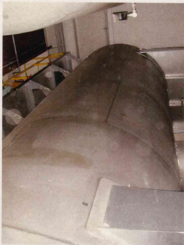
第1蒸留塔供給槽の破損状況
