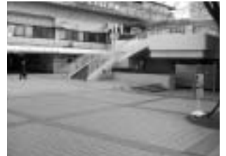
●人通りのほとんどないエスカレーター設置予定場所
