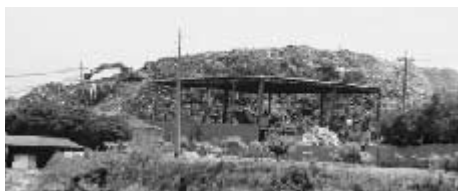
ゴミが山積みされた勘八町の処分場
