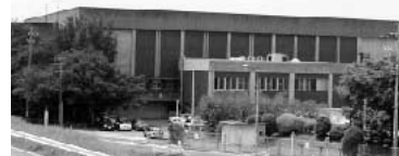
現在の豊田市体育館
