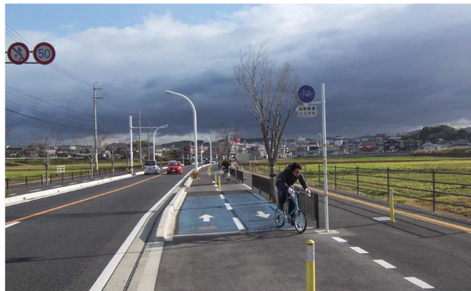
豊田スタジアム東(広川町)から整備が進む自転車道
