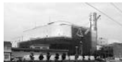
●8月から試運転に入る豊橋市のキルン式ガス化溶融炉方式の清掃工場
