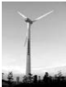
●日本食品(株)の風力発電施設
