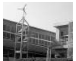
●東広瀬小学校の風力発電装置
