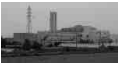
●4月から本格稼働を始めた豊橋のガス化溶融炉。課題が山積している模様
