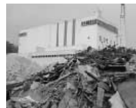
稼働を停止していた藤岡プラント
