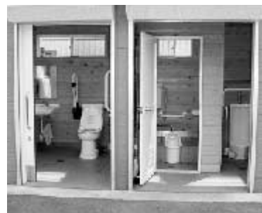
ベビーシートも設置されている多目的トイレ
