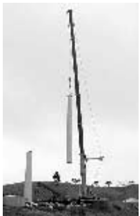
1号機支柱設置工事
