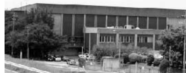
現在の豊田市体育館
