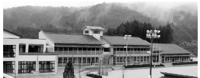
一部屋上緑化を実施している下山地区の巴ヶ丘小
