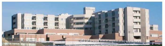
平成20年1月開院の豊田厚生病院
