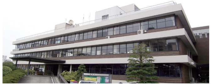
建替え計画が延期された東庁舎。新庁舎(保健センター)は建築費97億円を予定
