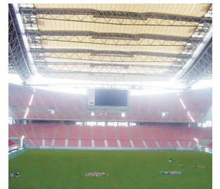
6,576万円かけ修繕した開閉屋根
