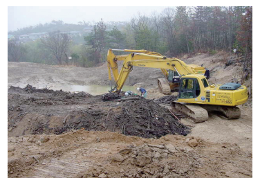
深見町岩花でのフェロシルト除去作業
