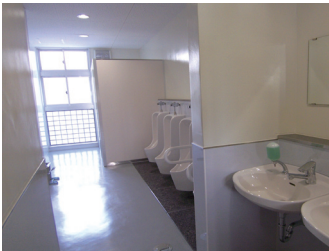
改修を終えた井郷中のトイレ
