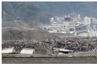
がれき除去作業が続く
