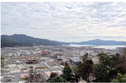
津波の被害により被災した町中心部
