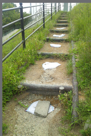
緊急修繕工事前
