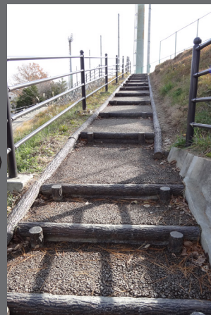
緊急修繕工事後
