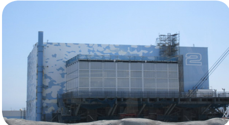
福島第一原発2号機。延々と続く廃炉作業を現地で確認
